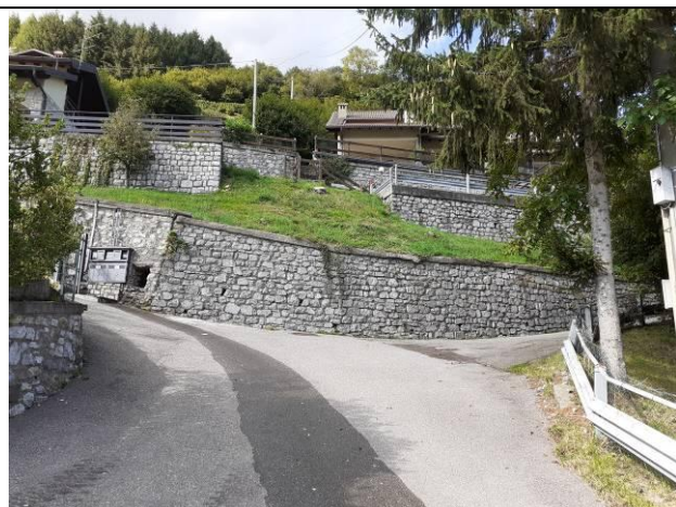
Rilievo fotografico area intervento
