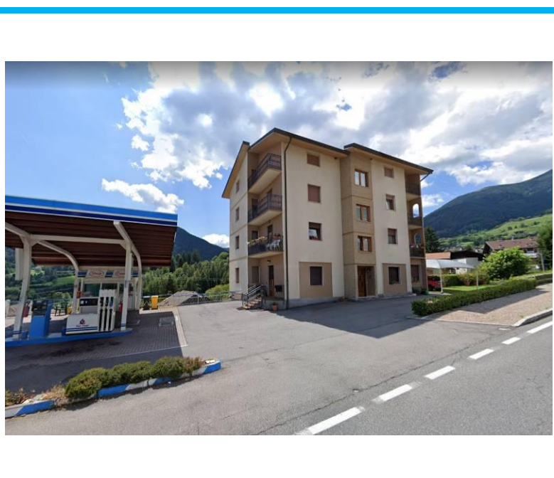
Distributore e fabbricato residenziale lungo la S.P. 5
