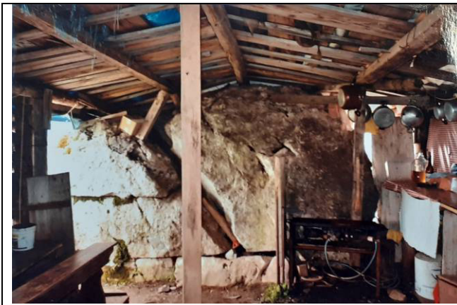
Rilievo fotografico riparo pastori esistente
